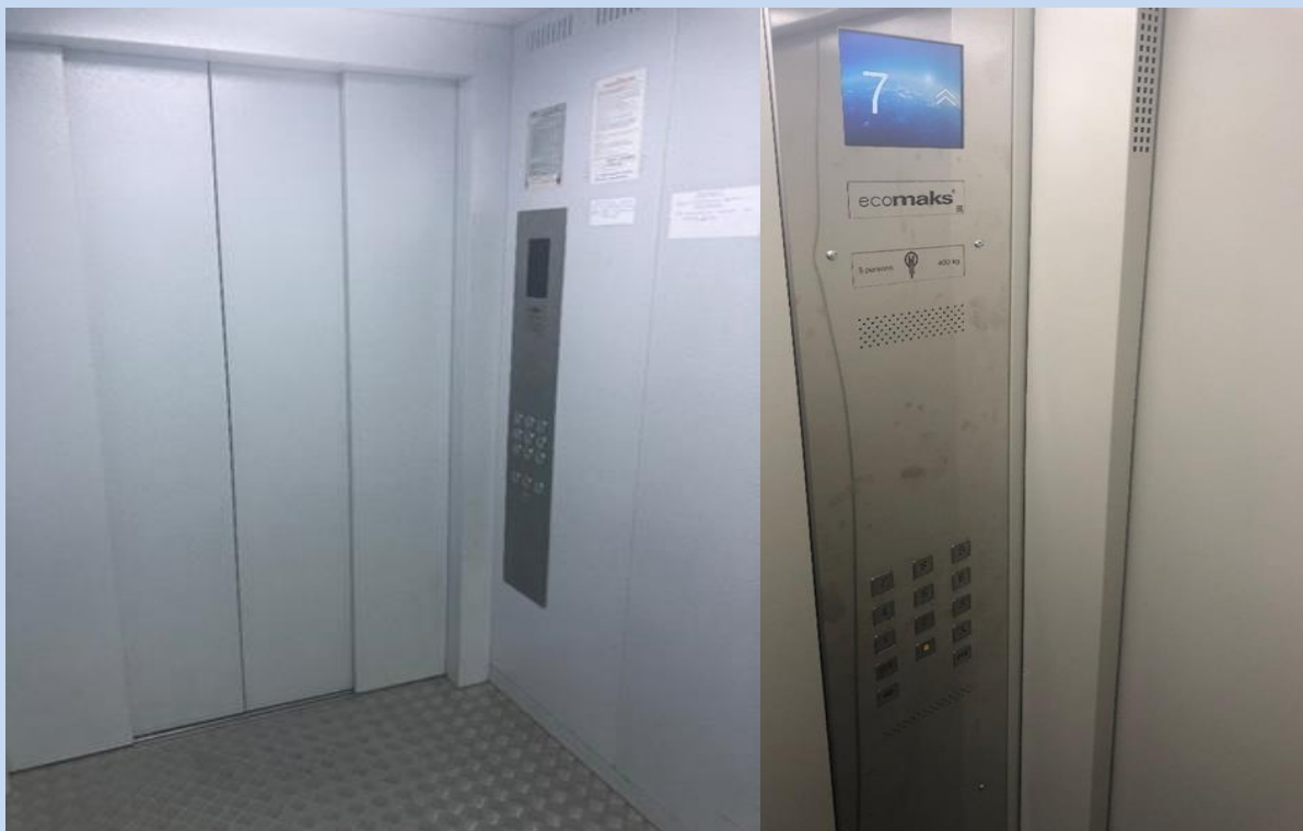
Капитальный ремонт по замене лифтового оборудования Клиники БГМУ
