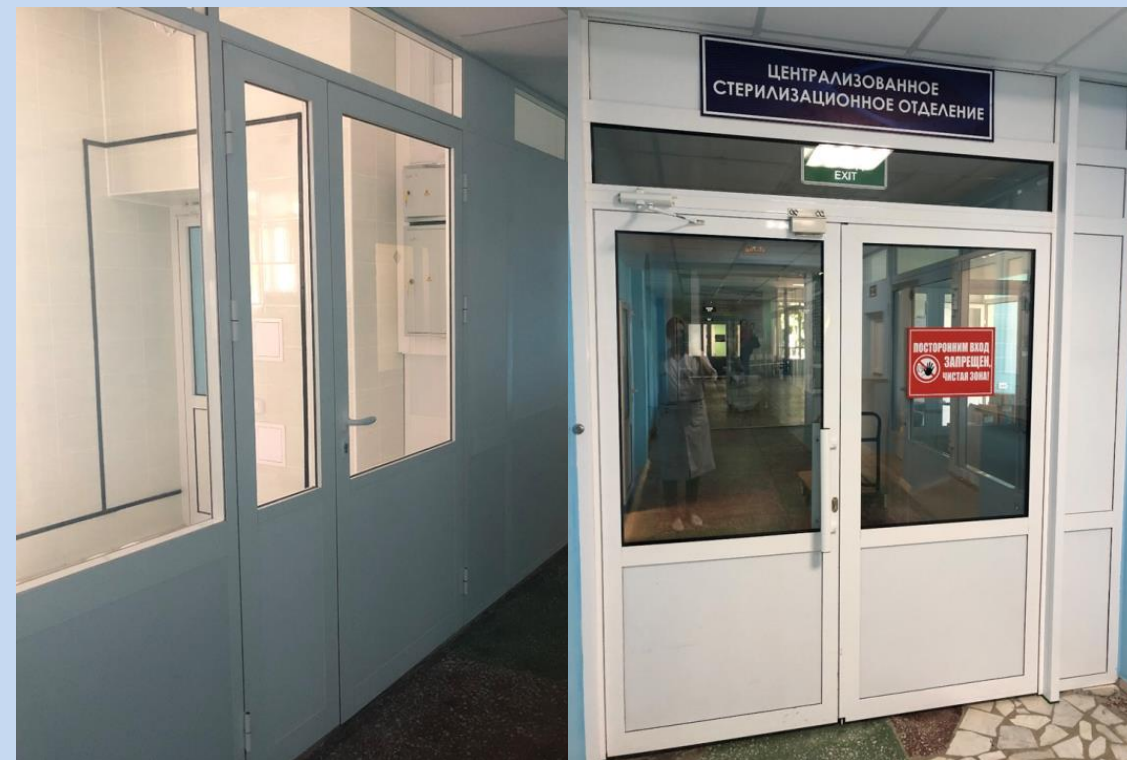
Капитальный ремонт ЦСО Клиники БГМУ
