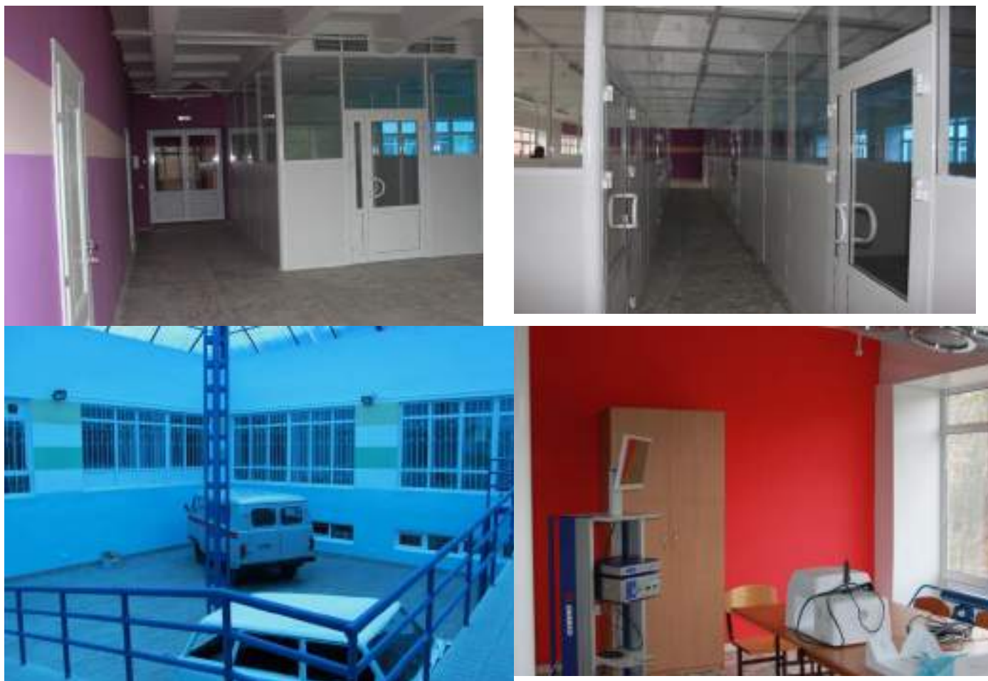
Рис. 49. Ремонт части помещений пищеблока Клиники БГМУ с размещением центра практических навыков
