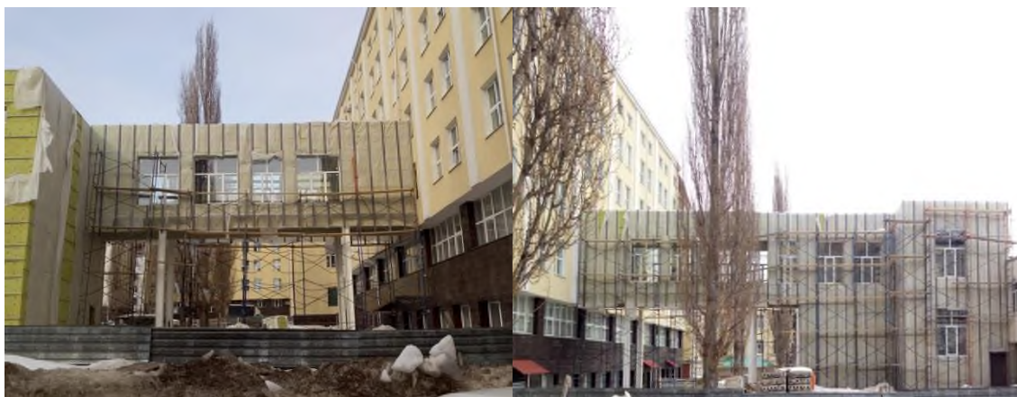
Реконструкция столовой с устройством перехода в учебный корпус №7
