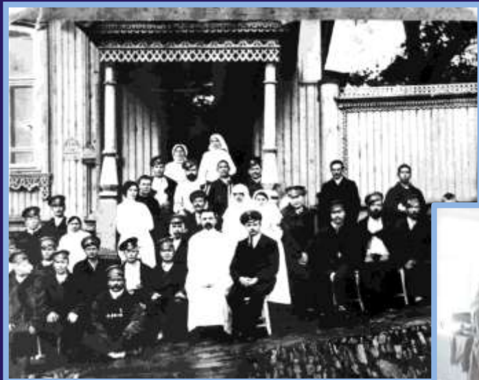
Госпиталь на улице Тукаева
