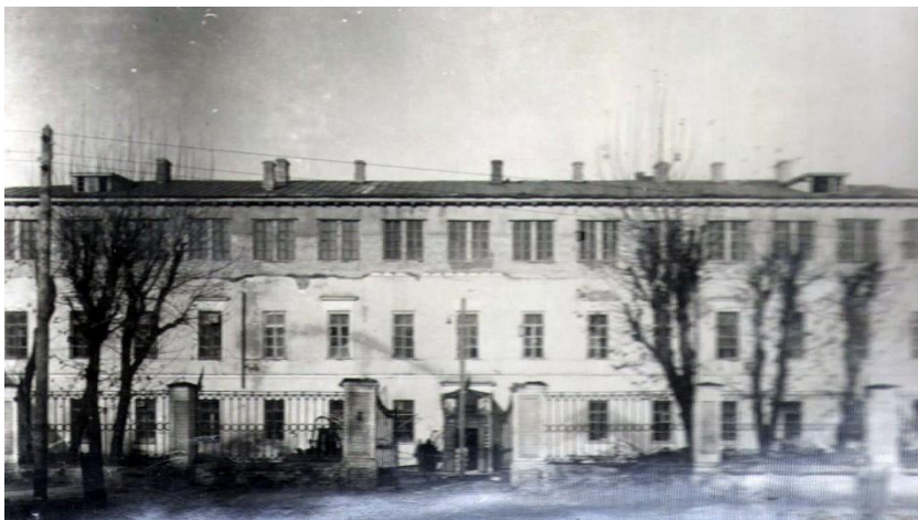
Здание стало трехэтажным (видна новая надстройка третьего этажа)
