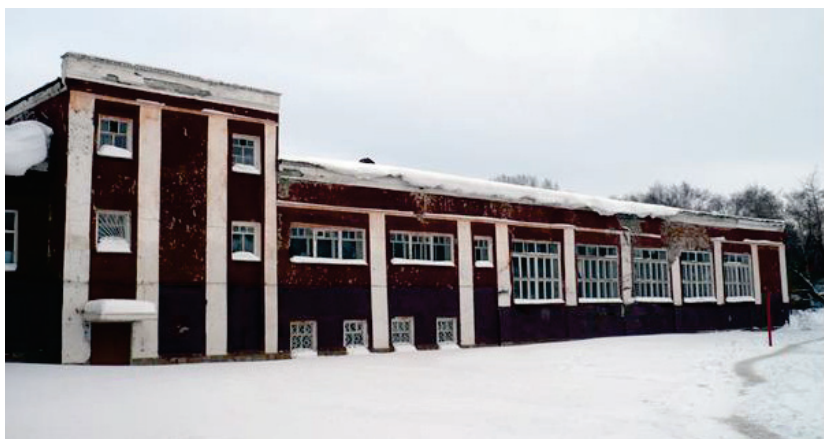
Эвакуационный пункт - ныне Клуб ТРЗ (со двора)
