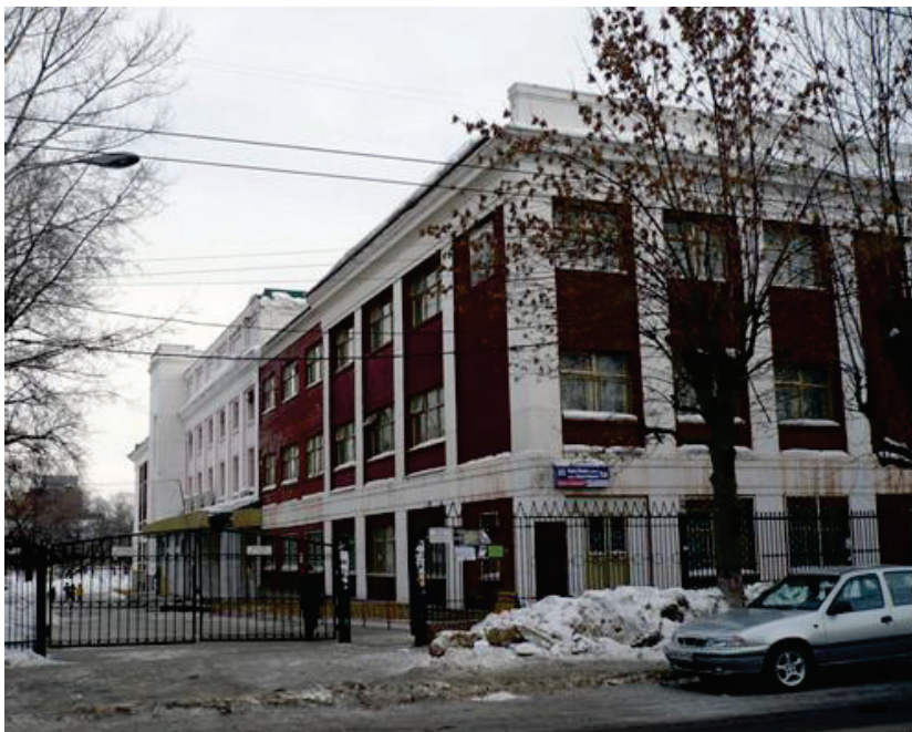
Эвакуационный пункт - (ныне центральное здание Клуба ТРЗ) (г.Уфа, ул.К.Маркса, 68)
