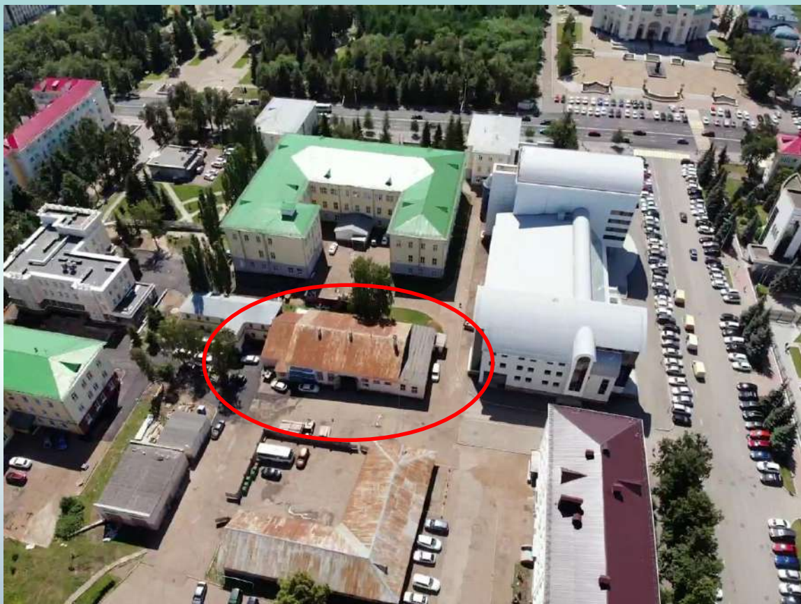
До начала реконструкции
