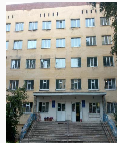
Капитальный ремонт объекта недвижимости, расположенного по адресу: г. Уфа, по ул. Революционная, д.74
