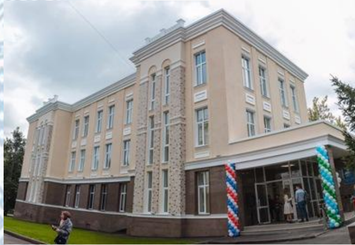
Реконструкция учебного корпуса №3 Объект сдан в 2019 г.
